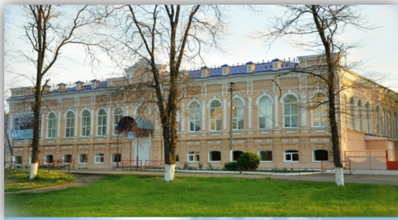
Здание №2 после капитального ремонта в 2008 году
